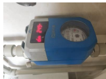
Watermeter+Swipe machine 收费水表
